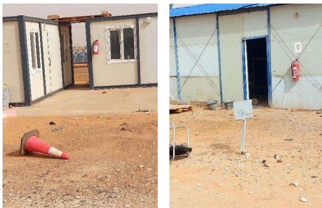
Photo 9 : Vues de quelques extincteurs à la centrale PV de Zouerate en septembre 2024 avec des spécifications conformes aux
