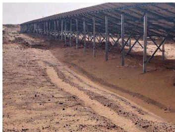
Figure 4 : Système de montage fixe de la centrale photovoltaïque
